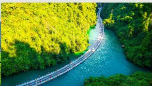
สะพานลอยน้ำสี่จ้อกวน
